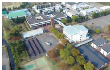
東京ドーム8個分の広大な八戸工業大学キャンパス
