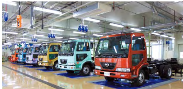
最新の設備を導入した自動車棟
